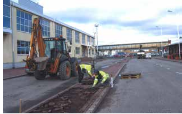
Vuonna 2008 matkustajasataman alueella korotettiin katuja ja kenttäalueita sekä nostettiin Kanavaniemen laiturin reunamuuria yleistyneiden tulvien takia. Ensimmäisen linja laatoitus- ja nostotyöt alkoivat huhtikuussa 2008 ja tulvaneston nostotyöt siltä osin valmistuivat kesäkuussa 2008.
