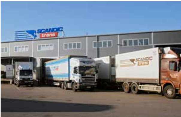
Scandic Transin uusi logistiikkakeskus valmistui Turun sataman välittömään läheisyyteen maaliskuussa 2003. Uudessa rakennuksessa oli monipuolisesti palveluja, kuten siirtokuormausta, käsittely- ja varastopalveluja.
