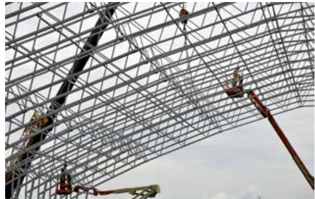
Vuosina 2004–2007 varastorakentamisen painopiste oli vahvasti Länsisatamassa, jonne rakennettiin kevytrakenteisia ristikkohalleja muun muassa Finnstevn, Mann Linesin ja Finnforestin tarpeisiin.
